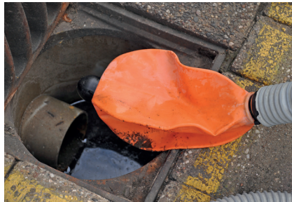
Befestigen Sie den ROM SmokeStopper am Ende des Nebelzufuhrschlauchs
