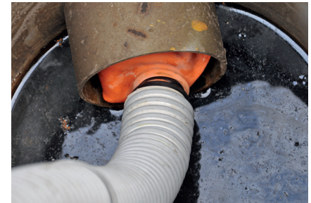
Das Rohr wird automatisch luftdicht abgeschlossen, sobald der Nebel durch den Schlauch geblasen wird
